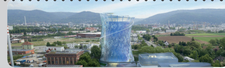
© LAVA Architekten Berlin/Stadtwerke Heidelberg
